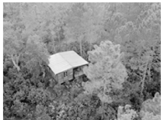
Vista exterior de la Maison démontable 6x6.
